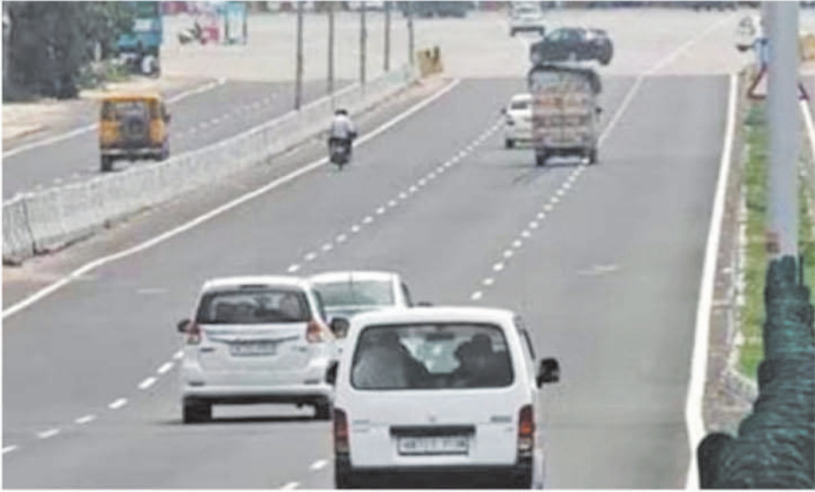
कहा गया कि वे गांव के पानी की निकासी की तुरंत व्यवस्था करें। एनएचएआई के परियोजना निदेशक से सड़क निर्माण की प्रोजेक्ट रिपोर्ट जल्द भेजने और तय समय में काम पूरा करने के निर्देश दिए। दो साल पहले शुरू हुआ था निर्माण : बघौला गांव में बनने वाले इस फ्लाईओवर का निर्माण कार्य वर्ष 2023 के जून
